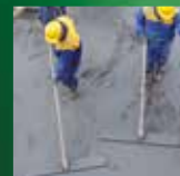
Vertido de hormigón
